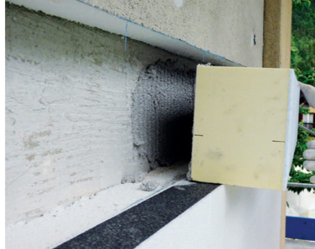
Einbringen des Brandriegels mittels Buttering-Floating-Verfahren
