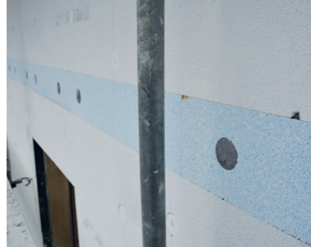
Ansicht des fertig eingebauten Brandriegels
