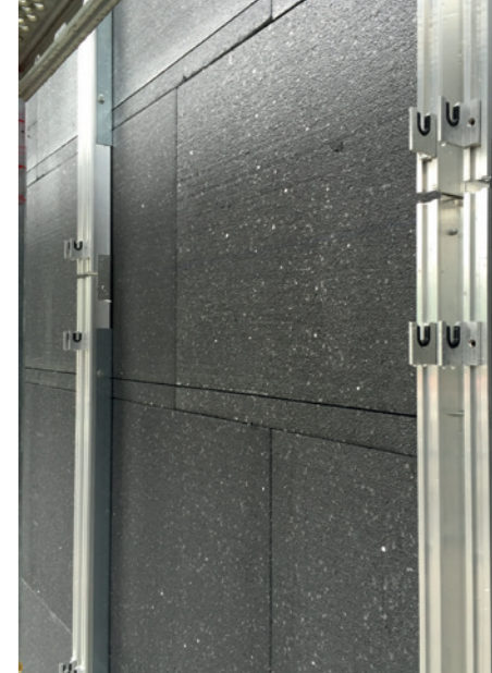
Vollständig verlegte Wärmedämmung mit befestigtem Trag- und Hinterlüftungsprofil
