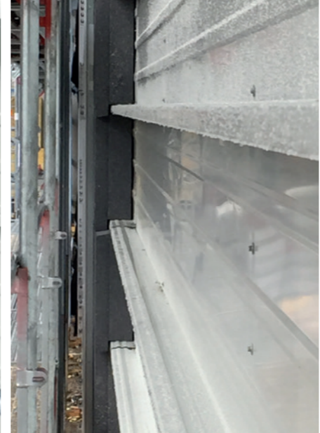
In die Wandkassetten eingebaute Wärmedämmung
