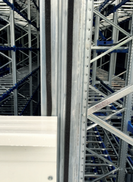
Montage der Wandkassetten auf Unterkonstruktion / Regalsystem
