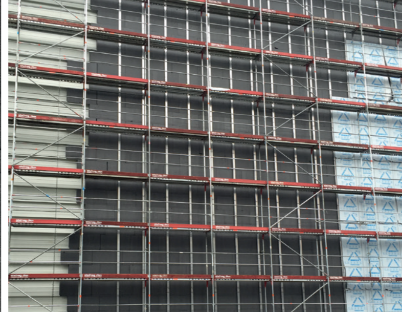
Fassadenteil mit fertig montierter Wandkassette, teils eingebauter Wärmedämmung und teils angebrachter Fassadenbekleidung (von links nach rechts)
