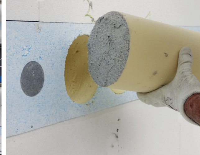
Qualitätssicherung zum Nachweis der einwandfreien Verklebung mittels Kernbohrung
