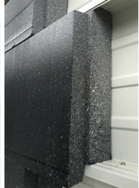
Die Verlegung erfolgt von unten links nach oben rechts
