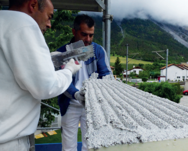
Mineralischer Klebemörtel wird vollflächig auf den Brandriegel aufgetragen
