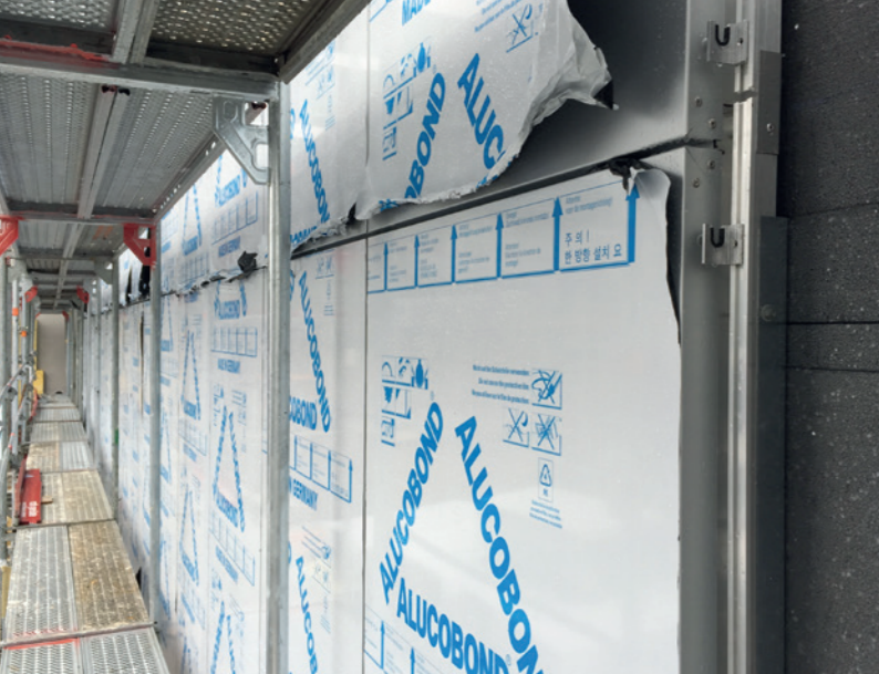
Auf die Trag- und Hinterlüftungsprofile angebrachte Fassadenbekleidung aus Alu-Verbundplatten
