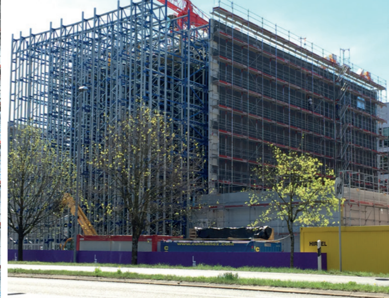
Aussenansicht Hochregallager während der Bauphase – Veranschaulichung der Silobauweise
