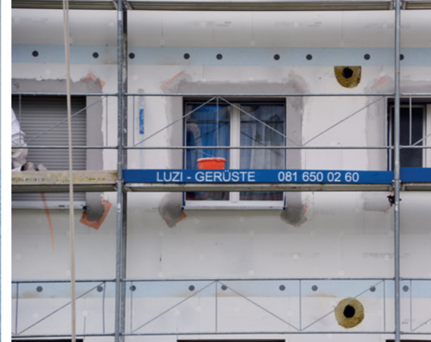
Ansicht des fertig eingebauten Brandriegels je Geschoss
