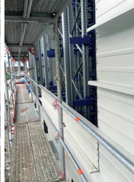
Montage der Wandkassetten auf Unterkonstruktion / Regalsystem
